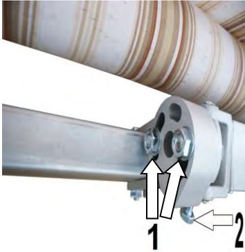
Fahren Sie die Markise aus. Lösen Sie die beiden Schrauben (1) etwas. Heben Sie den einzustellenden Gelenkarm der Markise um die Stellelemente zu entlasten. Über die Stellschraube (2) verstellen Sie die Neigung (Drehbewegung gegen den Uhrzeigersinn vergrößert den Neigungswinkel, der Arm bewegt sich nach unten / Drehbewegung im Uhrzeigersinn verkleinert den Neigungswinkel, der Arm bewegt sich nach oben).
