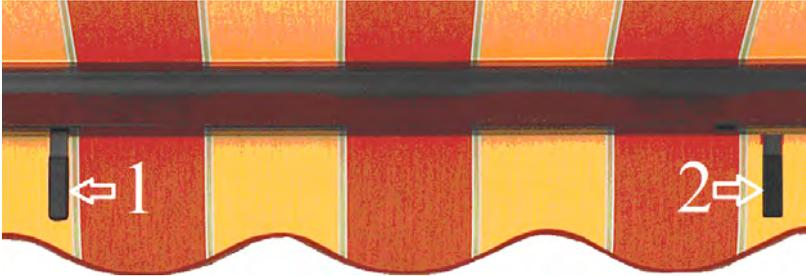
Bei der Gelenkarmmarkise sind am Ausfallprofil 2 Stahlwinkel (Armanschläge, 1 und 2 im Bild) montiert. Es handelt sich hierbei **nicht** um eine Transportsicherung. Die Winkel dürfen nicht entfernt werden. Die Armanschläge nehmen, kurz bevor die Markise schließt, die Gelenkarme gleichmäßig mit zurück und verhindern zudem, dass die Arme im eingefahrenen Zustand ausklappen können.
